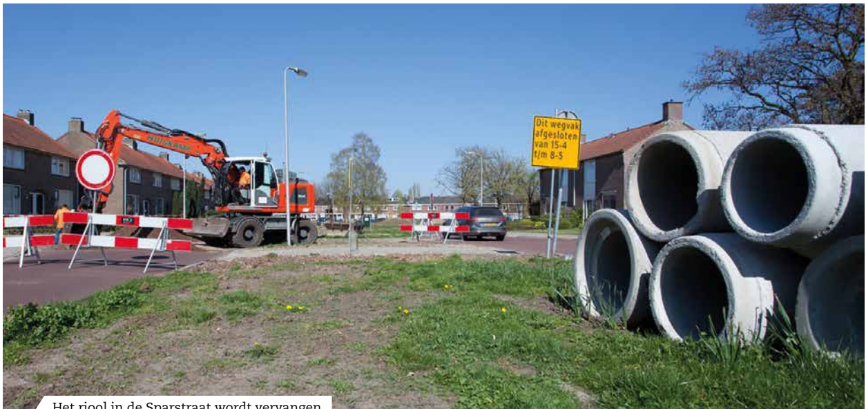
Het riool in de Sparstraat wordt vervangen
