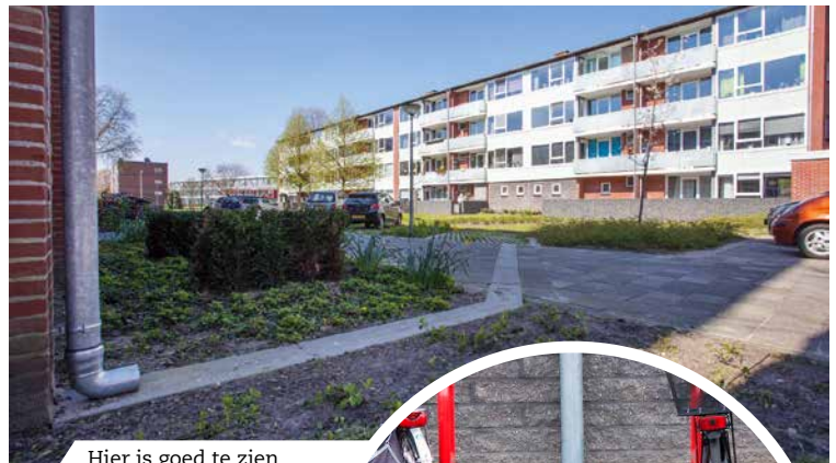
Hier is goed te zien hoe het regenwater is afgekoppeld
