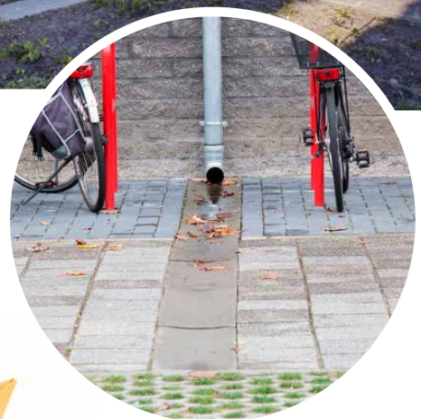
Hier is goed te zien hoe het regenwater is afgekoppeld
